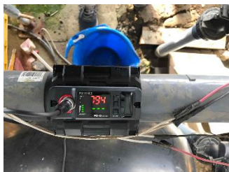
流量計 [超音波式] (キーエンス社製)
