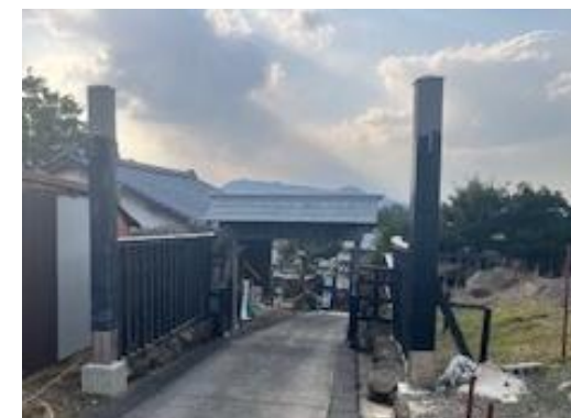
RE:BASE 整備予定地
